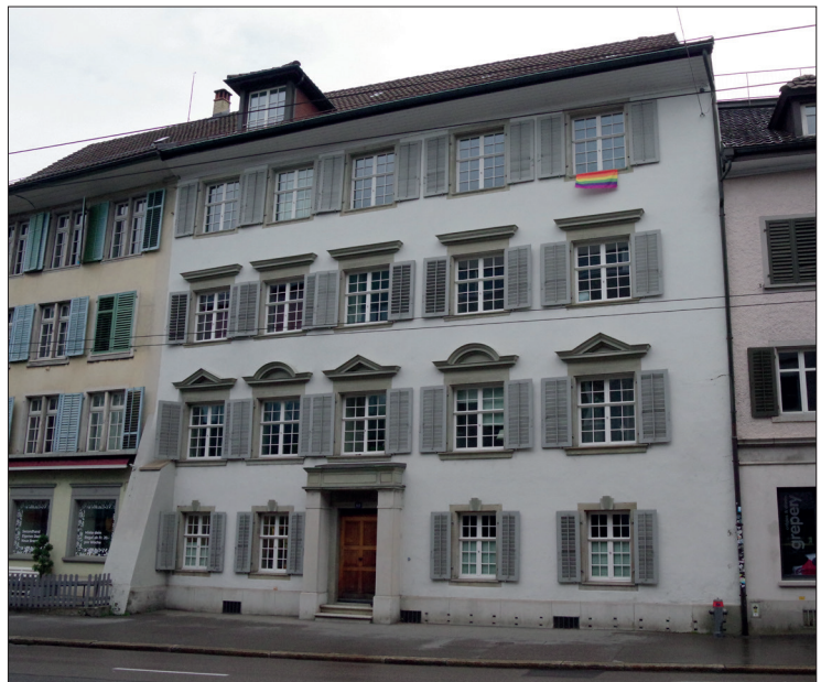
Technikumstrasse 68 - Schumacher- und Gerberstube – Zustand 2020.
